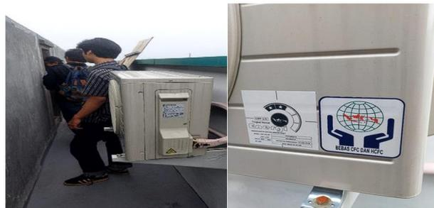
Gambar 3. Refrigeran tanpa ODP berupa AC tipe R32 yang sudah bersertifikat bebas CFC dan HCFC
