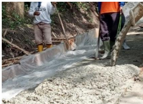
Gambar 13. Penuangan Beton
