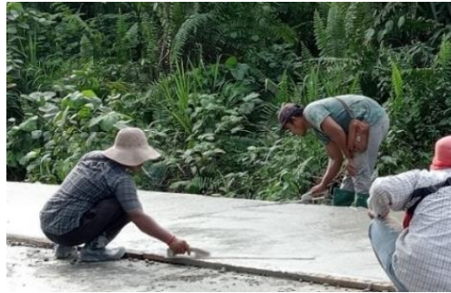
Gambar 14. Perataan Permukaan Beton
