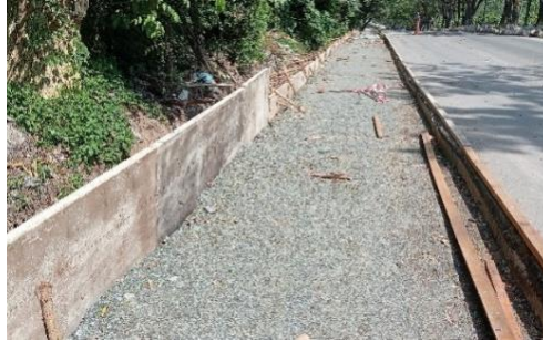
Gambar 8. Pemasangan Bekisting
