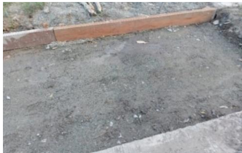
Gambar 6. Hasil Pemadatan Agregat
