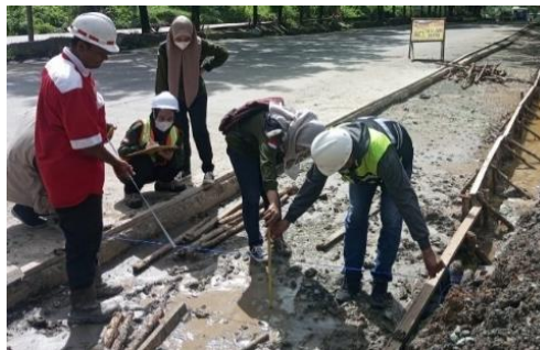
Gambar 12. Pengukuran Tebal Pada Bahu Jalan
