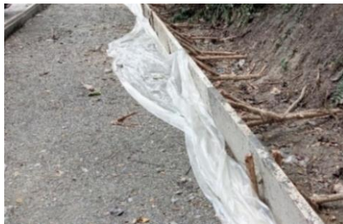
Gambar 9. Pemasangan Plastik Cor
