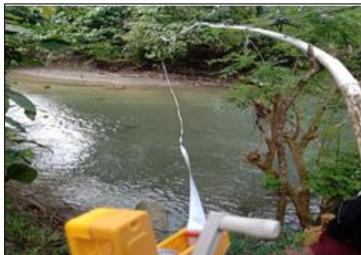
Gambar 2. Kondisi penyebrangan pipa eksisting
