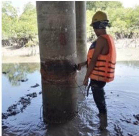
Gambar 3. Pekerjaan pembersihan tiang pancang.
