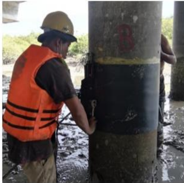
Gambar 7. Pemasangan HDPE pada tiang pancang
