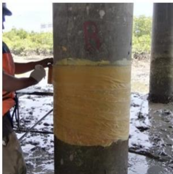
Gambar 6. Pemasangan petrolatum tape pada tiang pancang.
