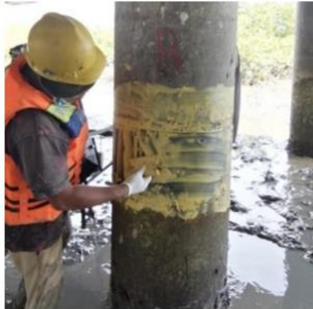
Gambar 5. Pengaplikasian petroleum paste pada tiang pancang.
