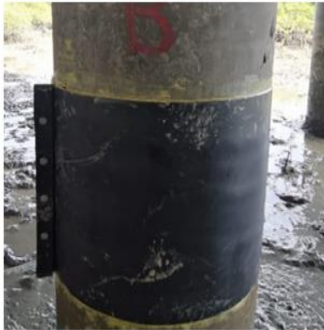
Gambar 8. HDPE jacket yang telah dipasang dan dikencangkan pada tiang pancang.
