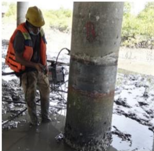
Gambar 4. Pekerjaan penggantian pelat sambungan baja.
