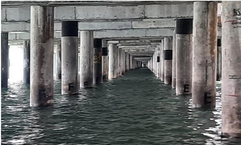
Gambar 2. Tiang pondasi sebelum dilakukan pelapisan ( coating )
