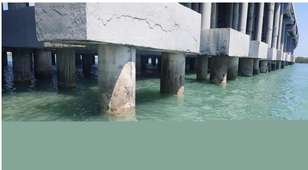
Gambar 3. Progres pelapisan ( coating ) pada tahap 50 %
